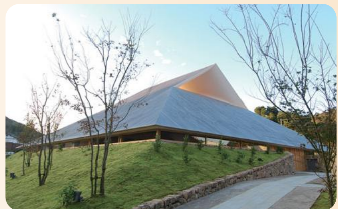
直島ホール(香川県 直島) 建築:三分一博志 / 建築主:直島町
