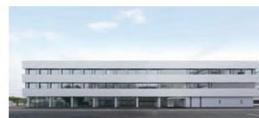
新実験棟外観(撮影:エスエス島尾 望)
