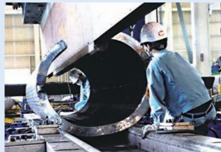
【プレス機による極圧鋼材曲げ加工】
