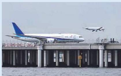
【羽田空港第4滑走路支える鋼管杭】
